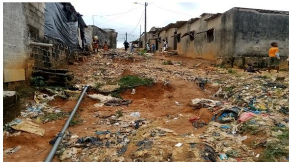
**Photo n°7 : Un poteau électrique dégradé par l'érosion dans le secteur de Ciel**
