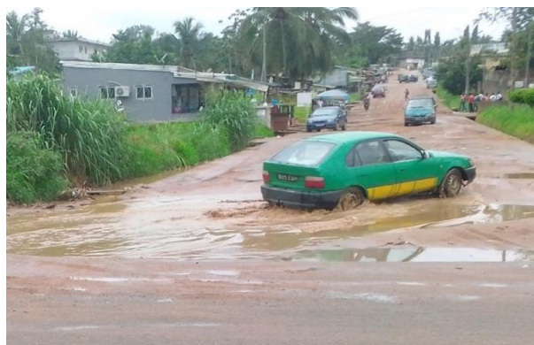
Photo N°7 : Un canal d'évacuation obstrué sur une voie bitumée au quartier Bagnéri
