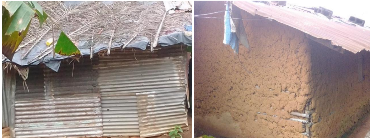
Photo N°9 : Un habitat précaire fait en tôle Photo N°10 : Un habitat précaire fait en terre battue
