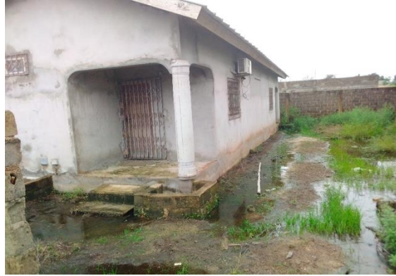
Photo N°14 : Un habitat construit dans une zone inondable
