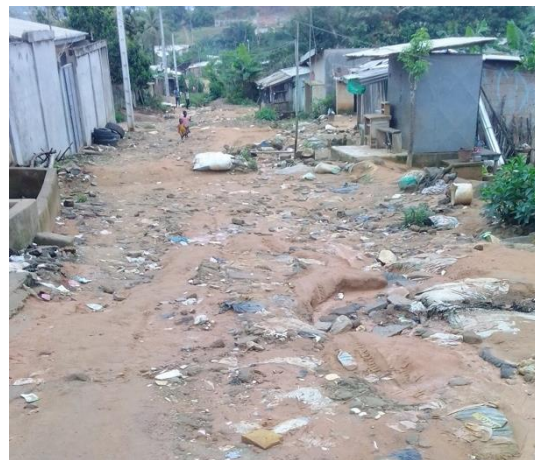
Photo N°5 : Une voie non bitumée dégradée au quartier Impérié
