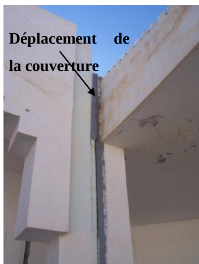
Photo 9: ouverture du joint de rupture n°2
