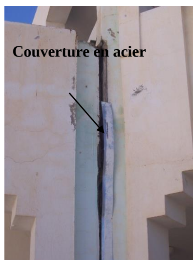
Photo 10: ouverture du joint de rupture n°3
