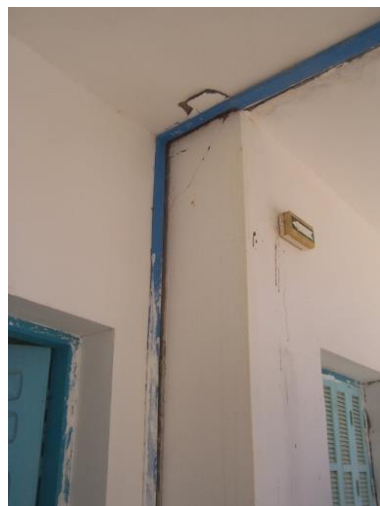
Photo 12: ouverture du joint de rupture n°4
