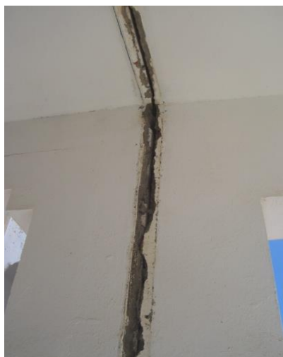
Photo 11: Ouverture du joint de rupture n°5
