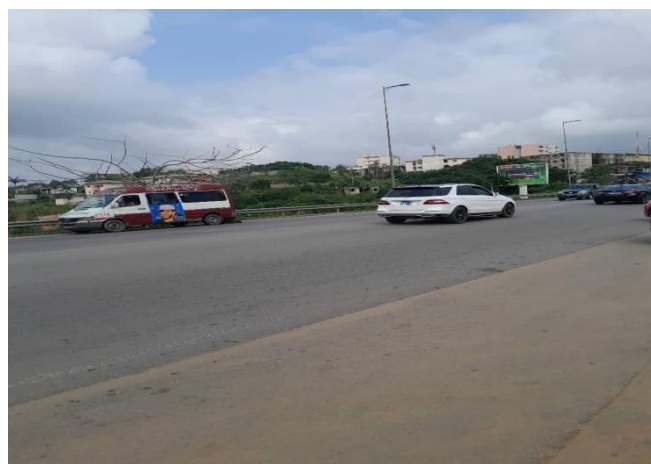
Photo b : Une voie bitumée satisfaisante
